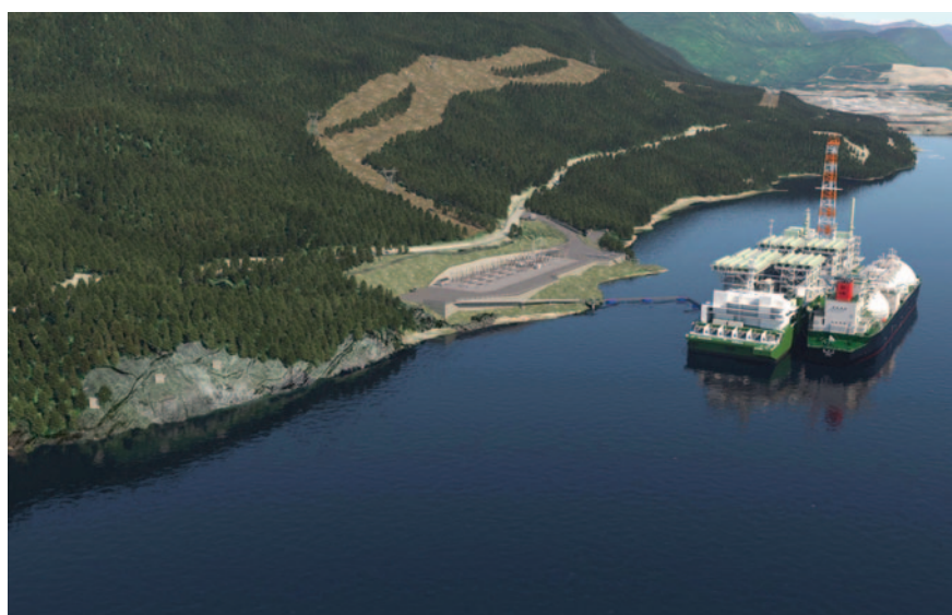
Courtesy of Cedar LNG
